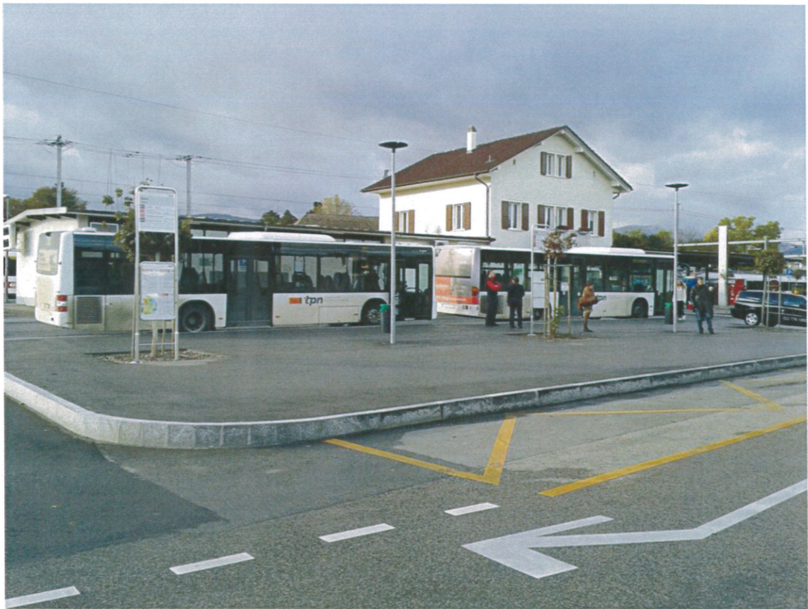
Image : vue de la Place devant la gare de Coppet et de la plateforme centrale pour l'accès aux bus
